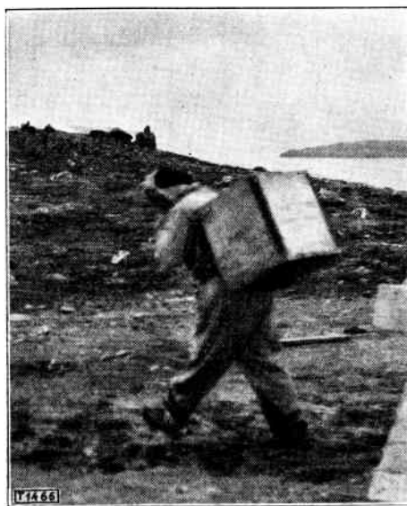
Fig. 8. Udbæring af beton ved støbning af mastefundamenter ved sendestationen.
