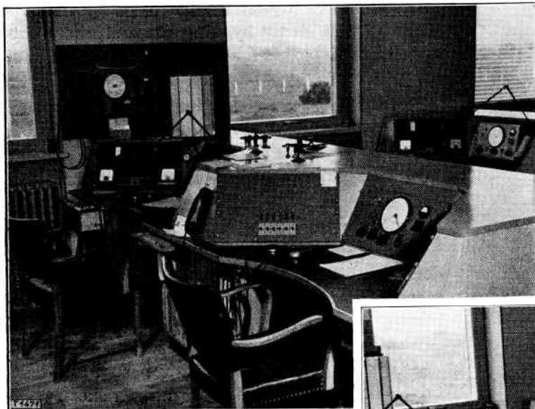
Fig. 13. Ekspeditionsborde. Telefoniplads til venstre, telegrafiplads til højre. Reserveplads i baggrunden. Reservetelefonisender ses på væggen.
