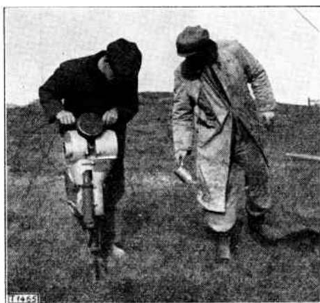
Fig. 7. Boring i klippen for sprængning til kabelmast.
