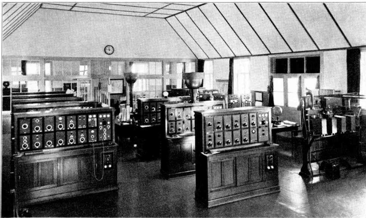
Fig. 2: Modtagersalen med Langbølgemodtagerne i Forgrund.
