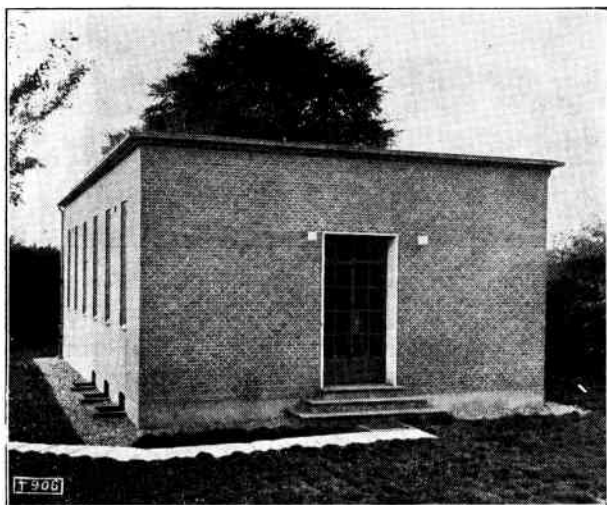
Fig. 6. Automatcentralbygning for 1000 abonnenter (Vojens).
